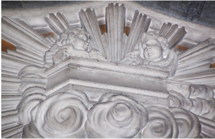
Fig. 5 – Frontão no Arco da Capela de N.ª Sr.ª da Boa Morte (pormenor)
