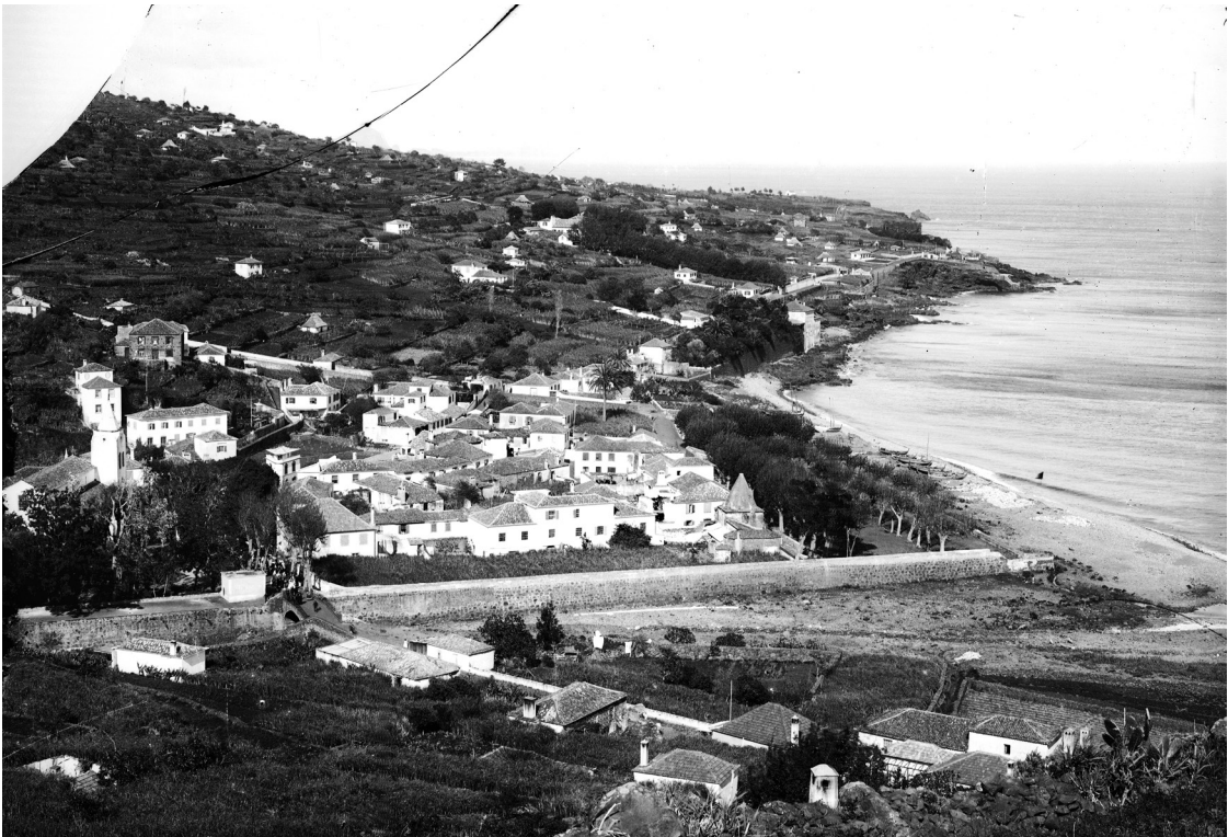
Imagem n.º 2 – Forno de cal em Santa Cruz (entre 1875 e 1899)
