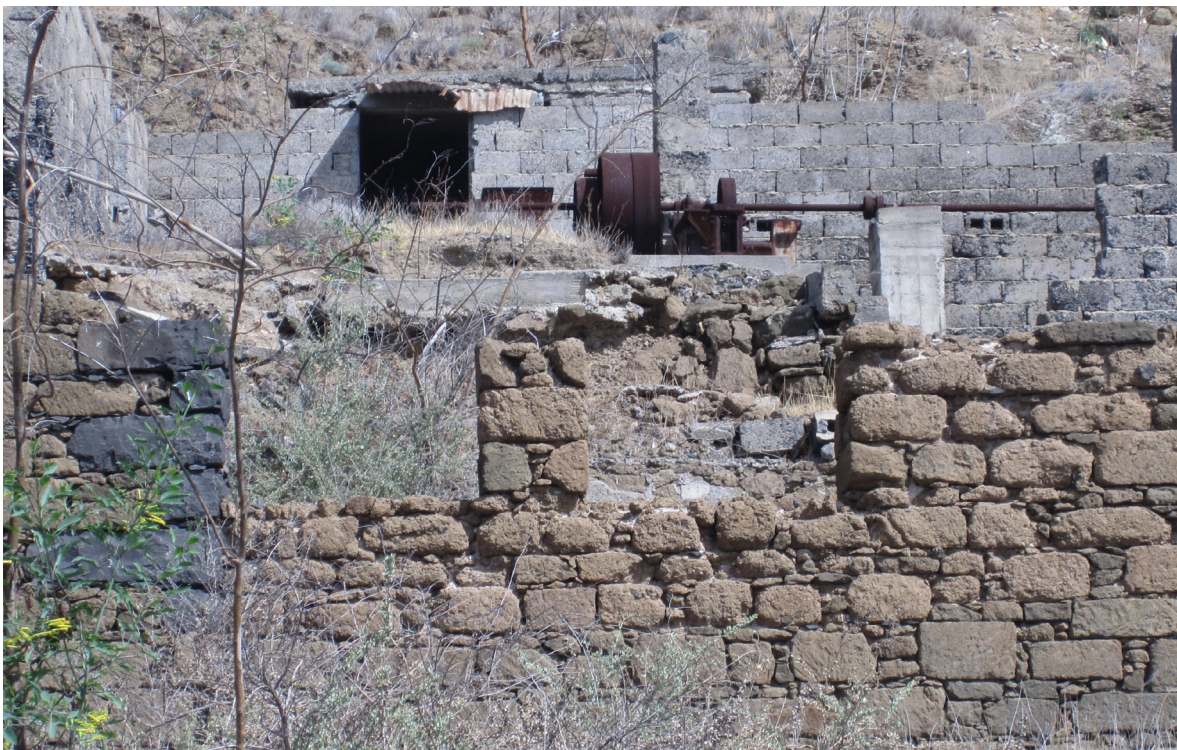
Imagem n.º 4 – Aspeto de pozolana aparelhada usada nas paredes exteriores da fábrica, 2013
